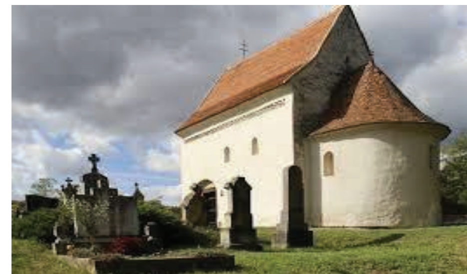
6. fénykép: A vasboldogasszonyi román templom, Sallából származó római építőkövekkel
